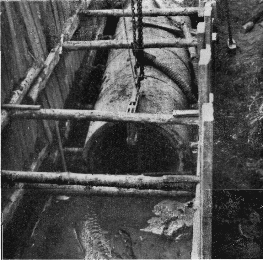
Afløb fra Gedved sø. Nedlægning af dybtliggende rørledning under vanskelige jordbundsforhold.
