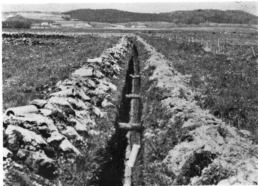
Dræning i Ø. Alling. Tværs henover den nye ledning ses et drænsystem lagt for år siden efter 800 kr.-loven. Afløbet for det nye og det gamle system er samme sted og har samme kote.
