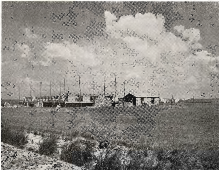
En ejendom under opførelse på Østerheden i Sdr. Vium.
