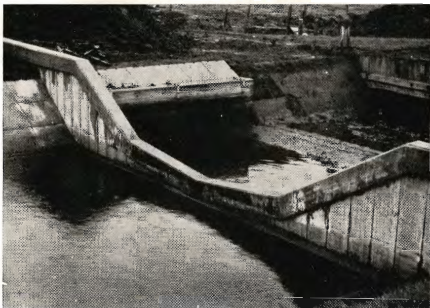
Styrt ved Simested å under udførelse. Billedet viser tydeligt udformningen af overfaldskanten. Denne udformning er foretaget for bedst muligt at sikre fiskenes opgang over styrtene under alle afstrømningsforhold.
