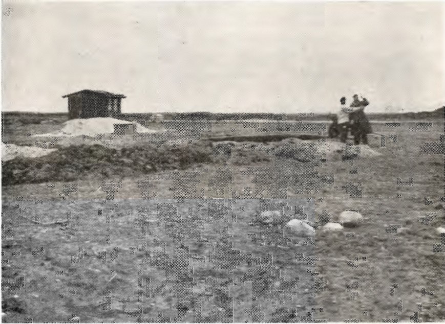
Udgravningen til bygningerne til den første ejendom på arealerne ved Sdr. Vium er begyndt i maj 1955. Ejeren bor midlertidigt i det lille skur i baggrunden. Få dage efter flyttede hans hustru og børn også ind i skuret.
