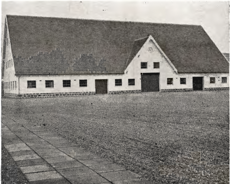
»Sivestedodde« i Kolindsund. Staldfacade mod øst. Opført 1949. Bygherre proprietær P. Pedersen. Bygningen har en længde på 34 m, bredde 19 m, højde 11,70 m og tagfladen måler fra tagskæg til mønning 12,55 m.
