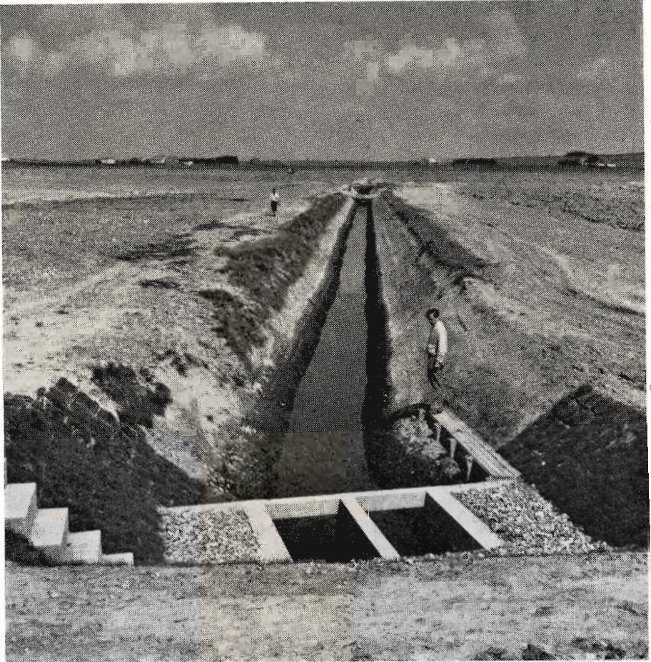
Pumpekanal i den inddæmmede Næs Vig. Det fugtige, mørke dyndlag træder frem i skråningssiden. Arealet er dybpløjet for at bringe dyndjorden frem til overfladen.
