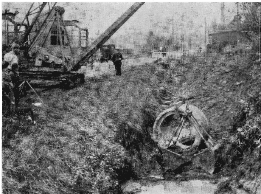
Gravemaskinen lægger røret på plads. Gennem røret ses overkanten af det sidst lagte rør og foran ses den anden gravemaskines grab ved at udgrave for det kommende rør. Rørleverancen til det omhandlede arbejde i Rævs å andrager godt 200 000 kr. Fot. I. C. P.
