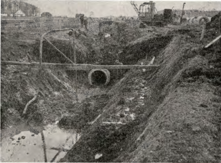
Nedlægning af 110 cm betonrør med fals i Røvs å. Rørenes længde er 110 cm, godstykkelse 17 cm og vægt ca. 1600 kg. Rørene lægges i en dybde fra 3,5 m til 6.0 m. Fot. I. C. P.
