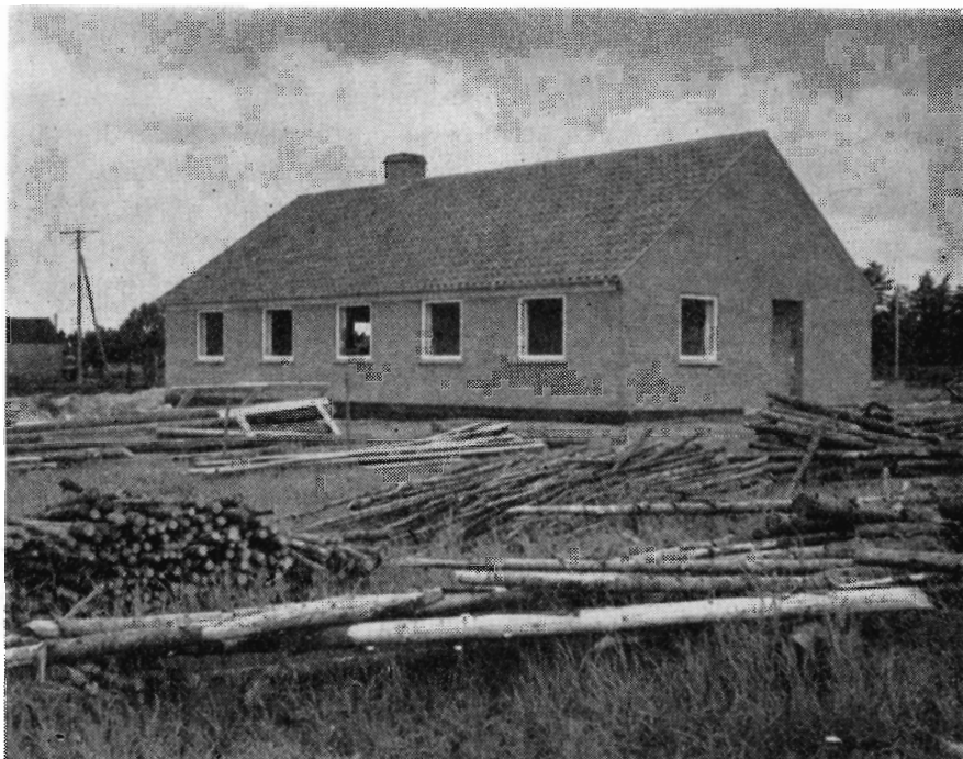
Administrationsbygning ved virksomheden i Brande under opførelse.
