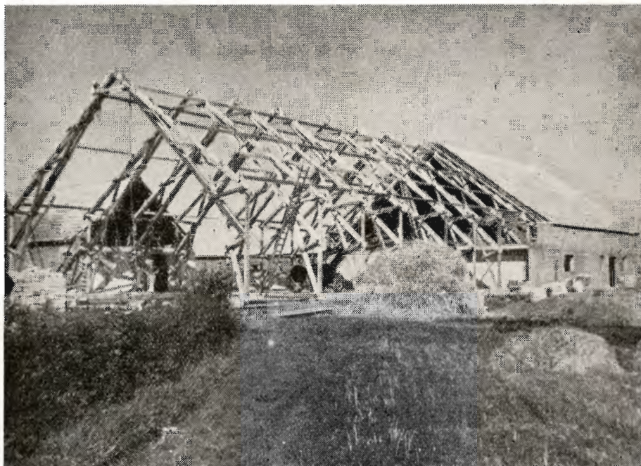
Fra hedeselskabets byggevirksomhed. Lade med fodercentral under opførelse hos gdr. Ove Sørensen, Jegstrup Skovgaard ved Hasselager.
