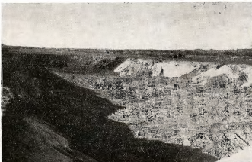
I Vindt Mølle mergelleje er der truffet aftale om, at den afrømmede overjord udplaneres over mergelgravens bund, således at denne bliver dyrkbar.
