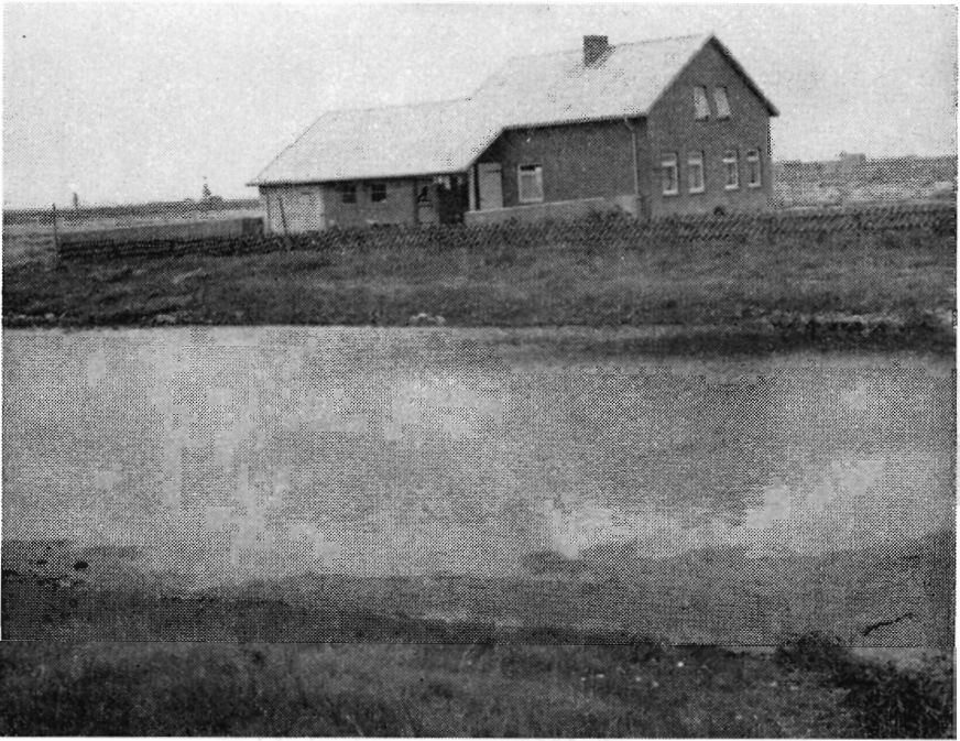
En mindre ejendom opført på nyindvunden marskjord. I forgrunden afvandingsskanalen.
