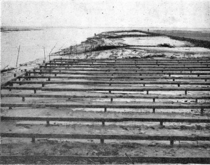
Beskyttelsesforanstaltninger for den nye marsk udenfor et af de tyske diger. Det er arealet langs vandløbet efter at det er gået gennem digets sluser, som man søger sikret mod strømvirkninger.
