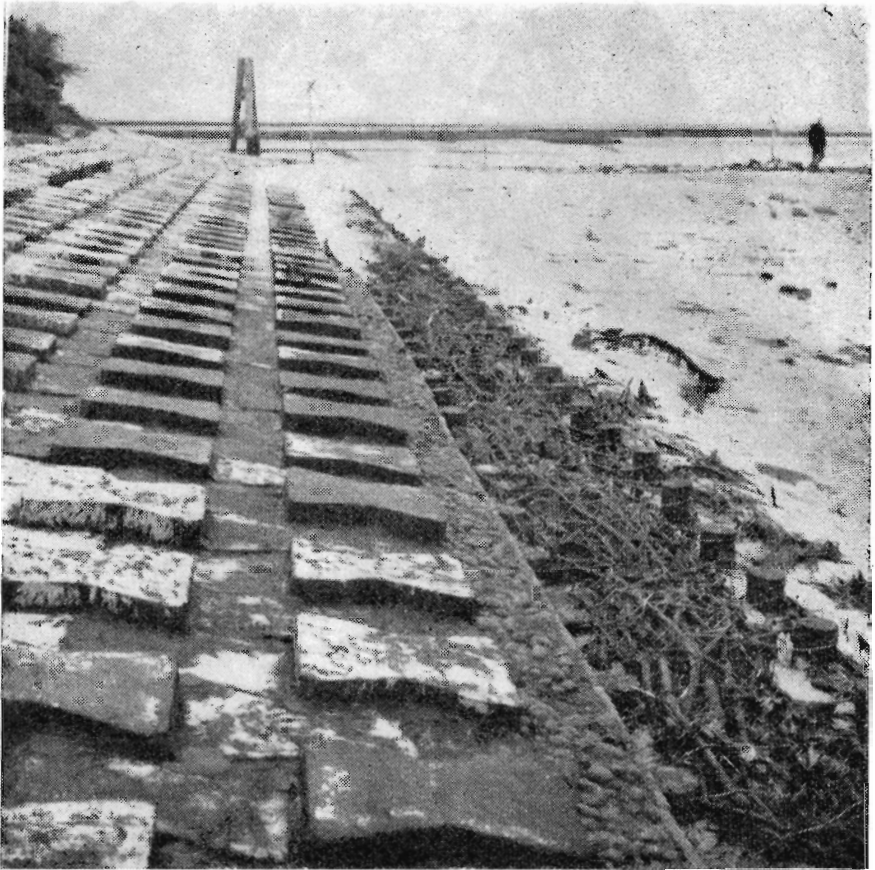
Beskyttelse af nybygget tysk dige langs Vesterhavskysten.
