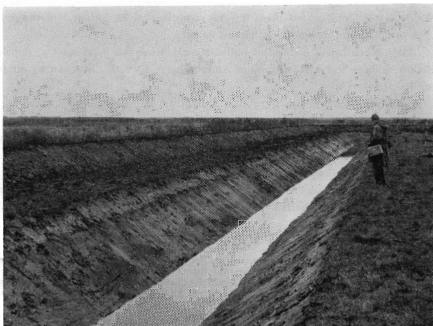
Pumpekanal med udenfor liggende dige omkring forsøgsarealet på klægjord i Stauning enge. Fot. novbr. 1962.
