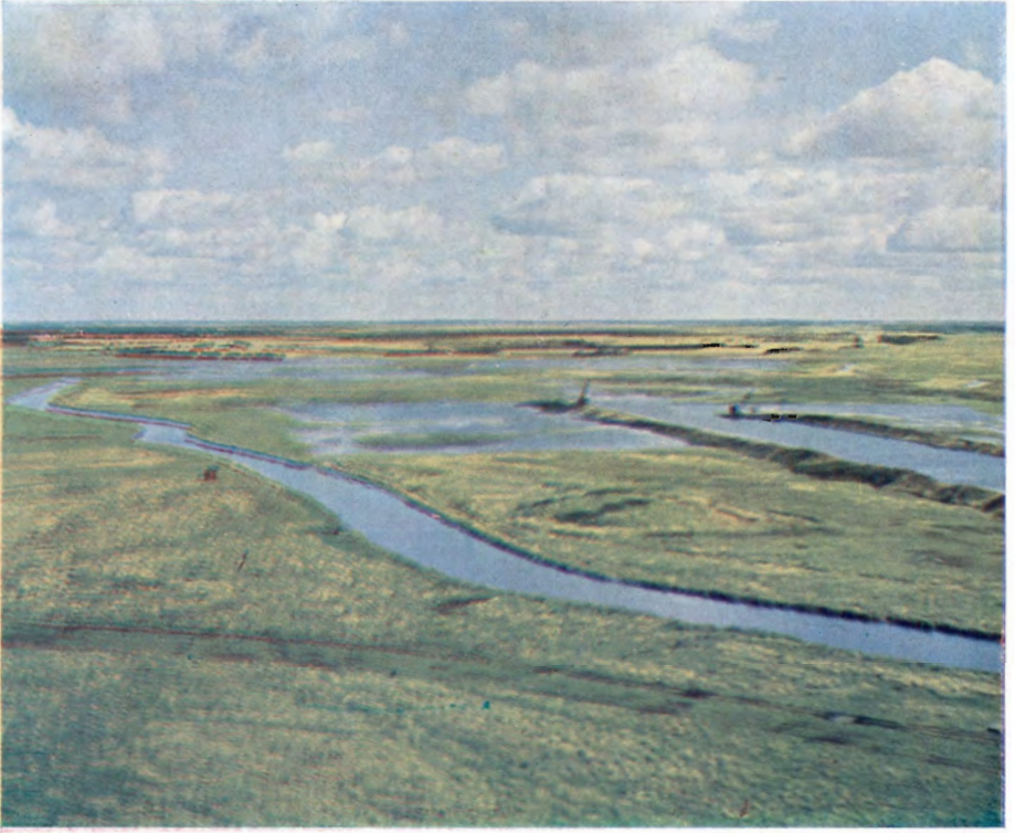
Skjernåens gamle og nye løb syd for Lundenæs den 31. august 1962. De store gravemaskiner ses omtrent midt i billedet.
