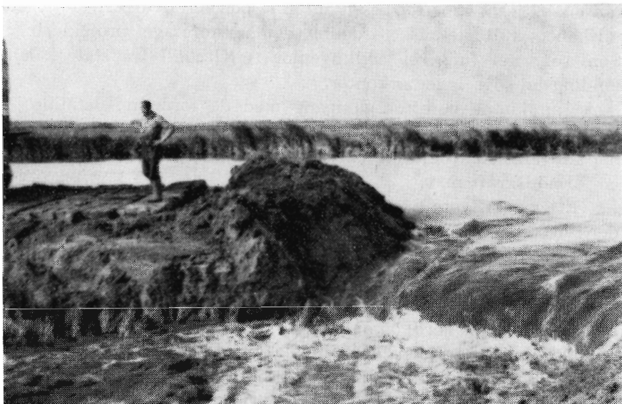
Entreprenøren er her nået så langt, at vandmasserne fra den gamle Skjernå kan lukkes ind i det nygravede leje.
