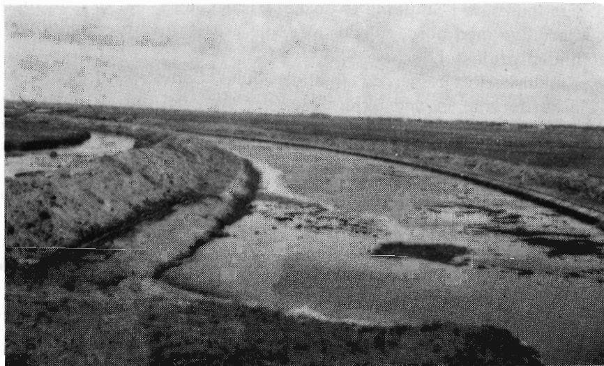
Det 45 m brede nyregulerede åleje omgivet af nye, men endnu uregulerede diger et par km øst for hovedlandevejen. Banketten bliver 4 meter bred og digets kronebredde 3 meter.
