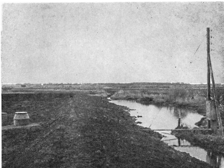
Dige og pumpestation ved forsøgsarealet i Aanum. Til højre i billedet ses det sivbevoksede, vandfyldte areal. Fot. novbr. 1962.
