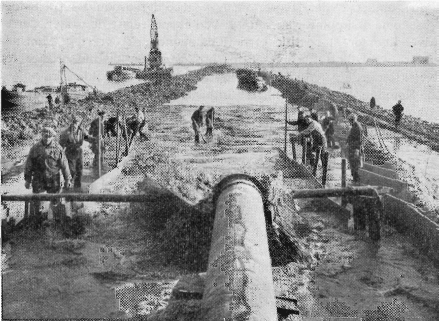
Afslutningsdiget omkring Øst-Flevoland er under bygning. Den indvendige fyld pumpes op.
