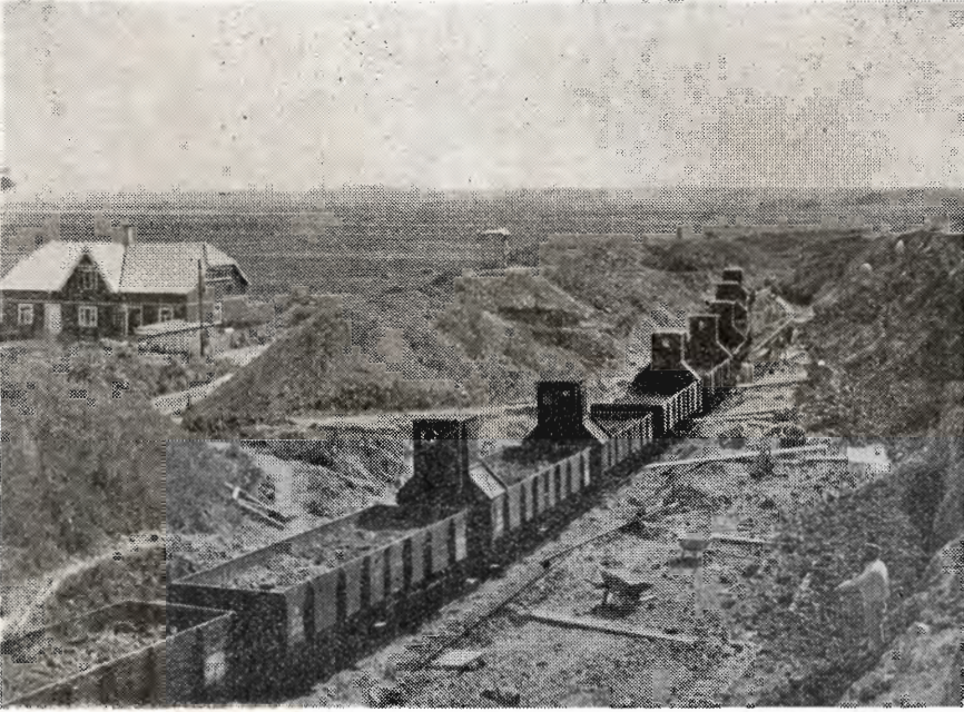
Fra Kjølens mergelleje ca. 1907, hvor en togstamme er ved at blive læsset. Fangerne fra Horsens tugthus udfører arbejdet med skovl og trillebør. Til venstre ses boligen for fangerne. Omtrent midt i billedet et læskur, hvorfra opsynsmanden overvåger fangerne.
