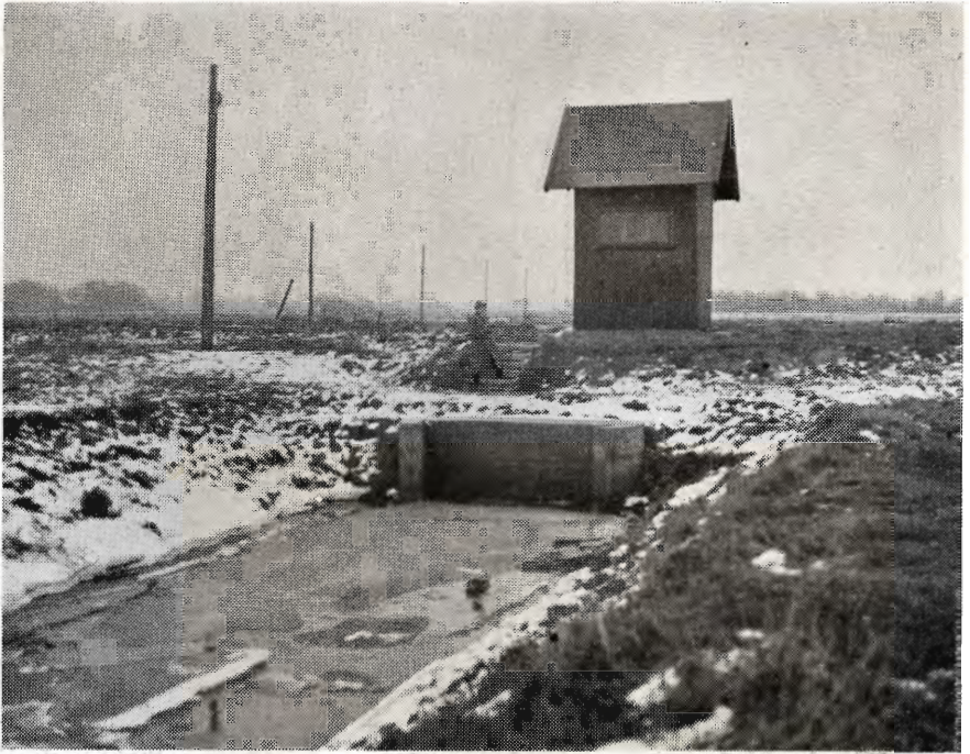
Fig. 6. En af de to små pumpestationer, der afvander Vejlbys-Egå mose. Pumpestationen er anbragt for enden af afvandingskanalen (Gl. Egå), og pumpen løfter vandet op i åen, hvor vandstanden normalt er omkring »daglig vande« i havet. Vandstanden i afvandingskanalen er ca. 1,50 til 2,00 m under havoverfladen. Pumpeanlægget er fuldautomatisk, idet pumpens elmotor igangsættes og stoppes ved hjælp af svømmere.
