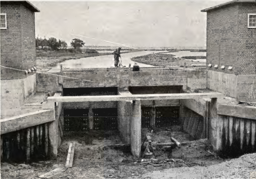
Fig. 3. Sluse- og pumpeanlægget ved Egåens udløb under bygning (set fra indløbssiden). Bygværket er endnu tørlagt, og man ser længst fremme i bygværket sluseportene i hvert af slusekamrene. I begge slusekamre ses indløbene til pumpekamrene, der er forsynet med riste til beskyttelse af pumperne imod overlast fra grøde, træpinde og lignende.
