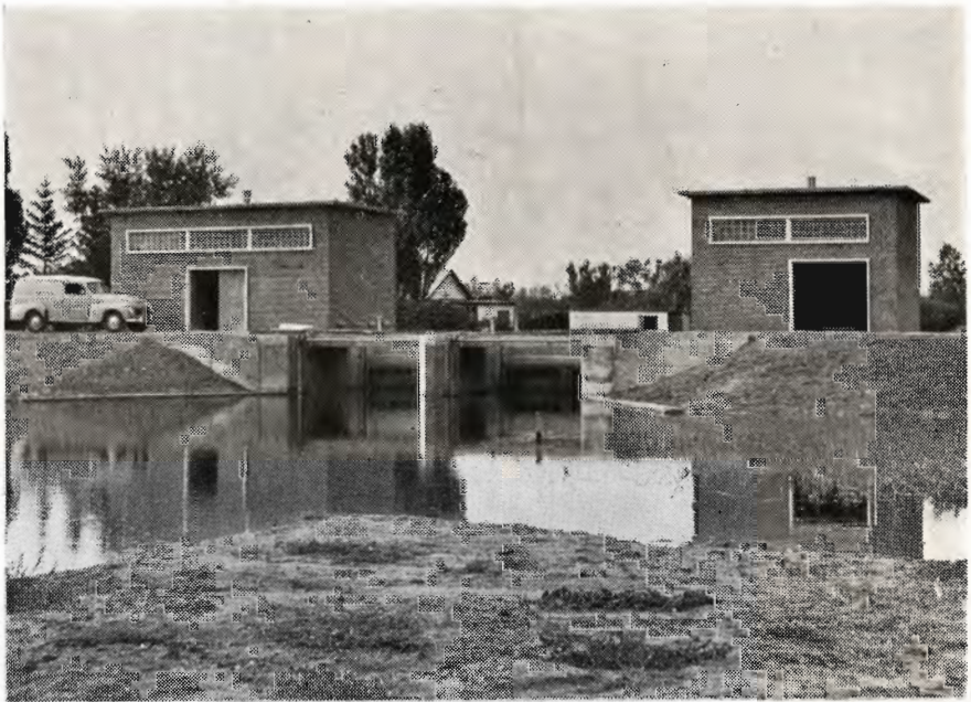
Fig. 2. Sluse- og pumpeanlægget ved Egåens udløb i Aarhus bugt, set fra udløbssiden (se også billedet på tidsskriftets forside). Slusen er delt i to kamre og på hver side af slusen er opført et pumpehus, hvert forsynet med en pumpe, der kan yde ca. 250 000 liter pr. minut. Tilsammen yder pumperne altså ca. ½ mill. liter pr. minut. Pumperne drives af 2 stk. 125 HK elektromotorer. Vandet presses ud under sluseportene, således at disse holdes fri for sand.
