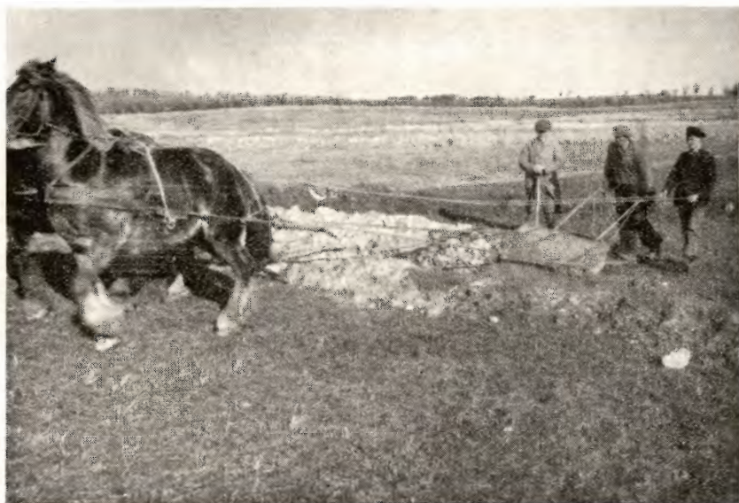
Muldskuffen er i Brug til Udjævning af den opgravede Jord fra Drængrøften.
