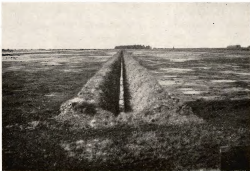
Tørveproduktion efter Hydropeat-Metoden. Tørvemassen ses her sprøjtet ud over Tørrepladsen.
