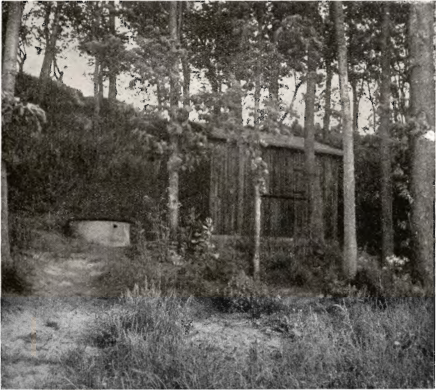
På Asmildkloster landbrugsskole har hedeselskabet oprettet et regnvandingsanlæg. På billedet ses pumpehuset, hvorfra vandet pumpes op fra søen og videre til vandingsanlægget. Fot. 1950.
