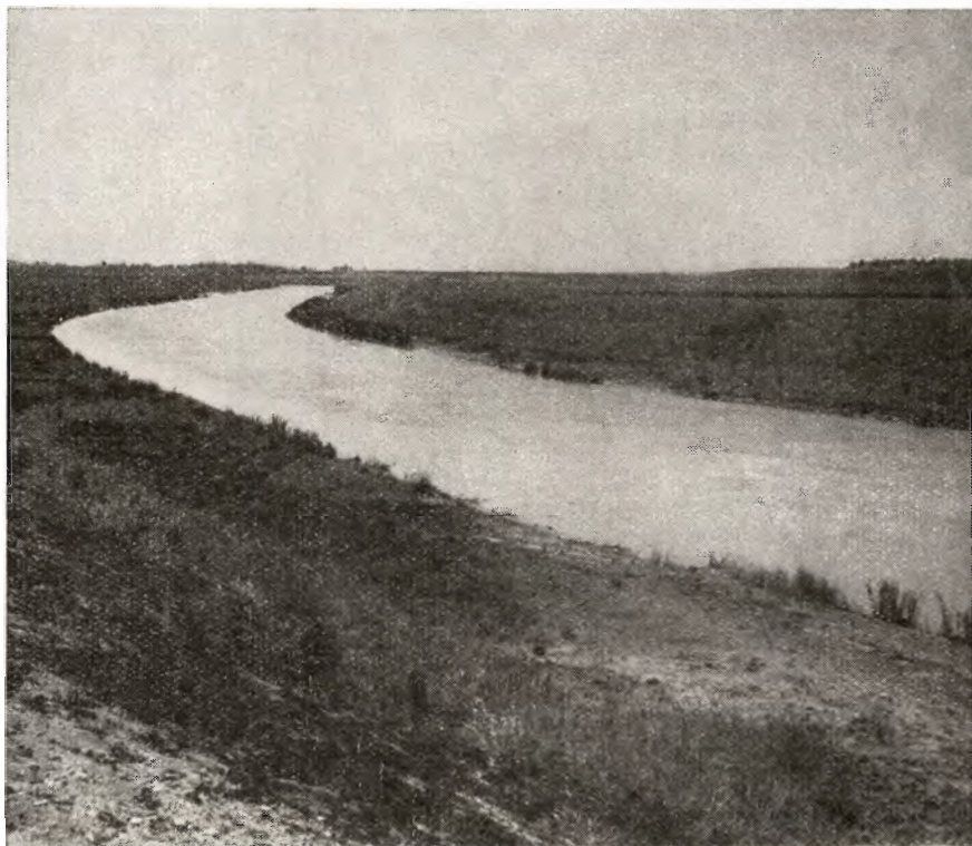
Skive-Karup å er her ført ind i det nye åleje, der er omsluttet af diger.
