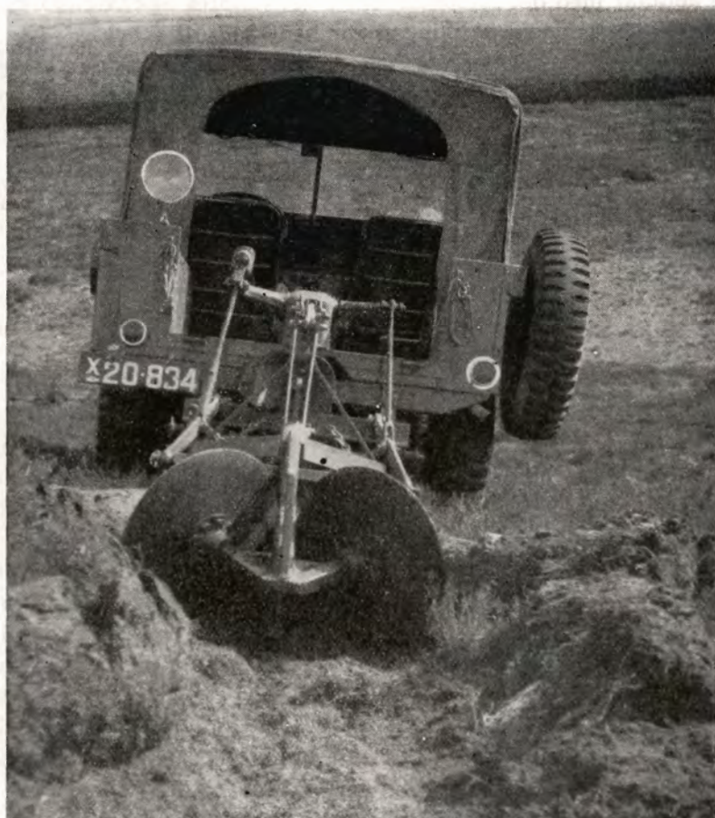
Hedeselskabets nye brandbekæmpelsesplow, »the fire-fighter«. Denne amerikanske nyhed er særlig bemærkelsesværdig ved de to rulleskær bag selve ploven, som bevirker at dobbeltplovens to furer kastes ud til siden.
