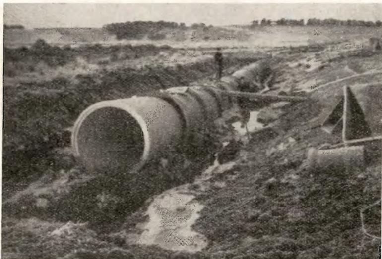
Rørlægning af et Hovedvandløb.
