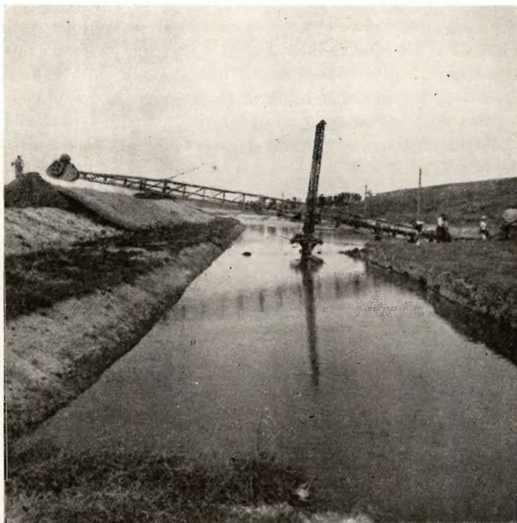
Transportør i Virksomhed med Udgravning af det nye Leje for Skive Aa ca. 5 km syd for Skive. Langs Aaens vestlige Side oplægges det nye Dige, der skal beskytte Engene indenfor. Der er 4 saadanne Transportører i Gang.
