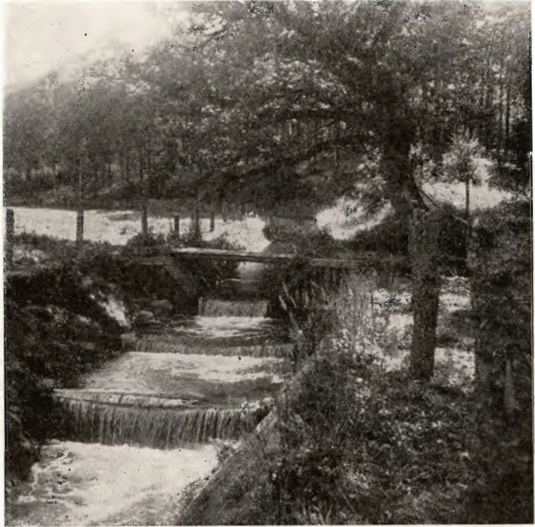
Reguleret Hovedvandløb med et tredelt Styr, der bl. a. tillader Ørrederne at gaa op ad Vandløbet.
