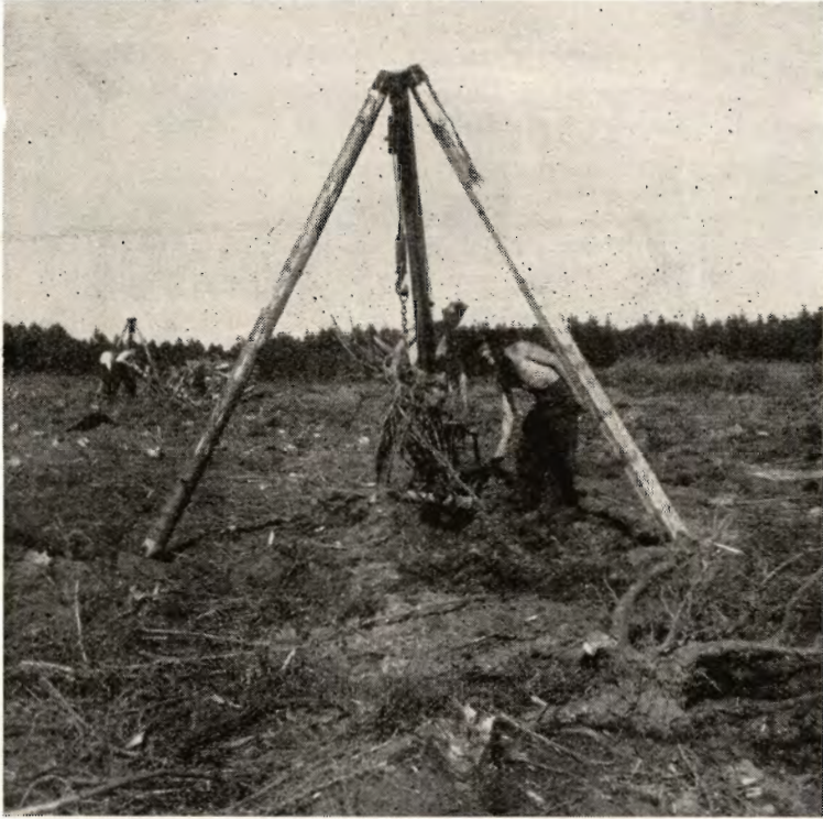
Stødotagning paa Areal i Plantagen Morville, hvor der, tvunget af de vanskelige Forhold, har maattet foretages Renafdrift.
