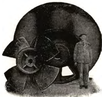
Dele til Pumpe for 4000 l Sek.
