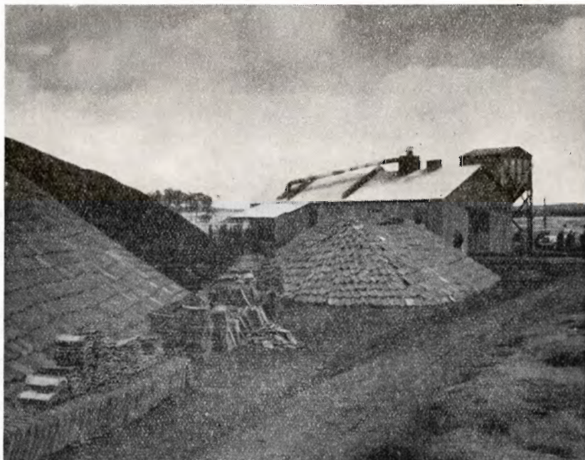
Brikkefabrik under Pindstrup mosebrug. De store stakke af affræsset tørvemasse er beskyttet med teglsten mod regn og vind.
