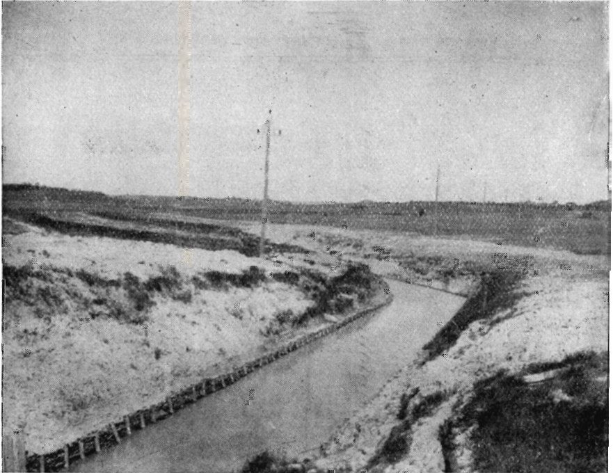
Hovedkanal med faskinsikring i Magleby Nor. Fot. 1950.
