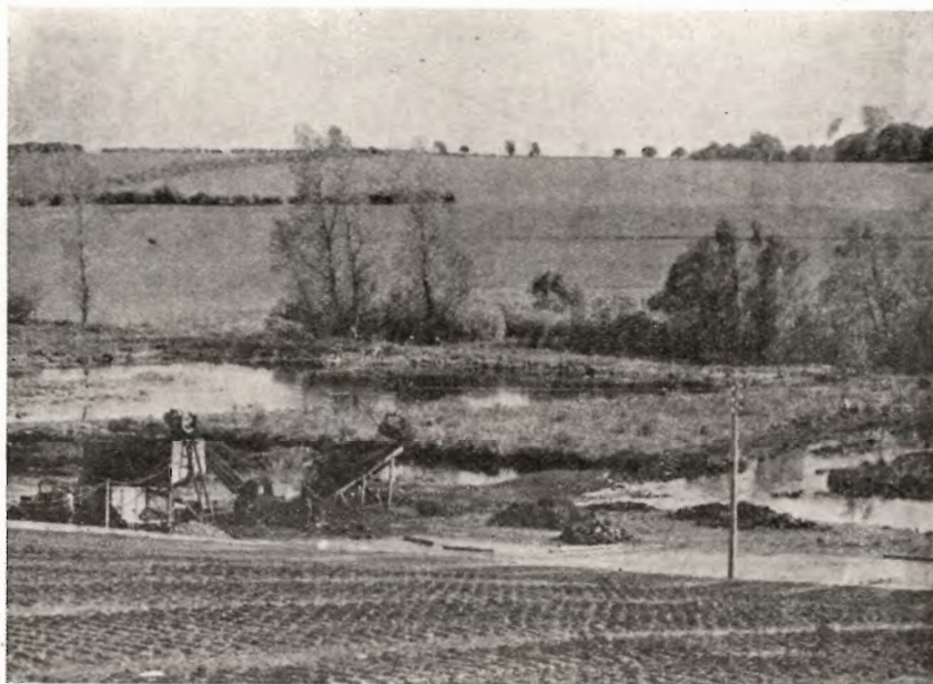
Et Slæbeskovlsanlæg paa Nyborg-Egnen. I adskillige Tilfælde er det ikke muligt at bortpumpe Vandet af Mosen. Der kan da benyttes et Anlæg som ovenstaaende. Tørvemassen transporteres til Ælteværket i en stor »Skovl«, der gennem Wirer trækkes af et Spil.
