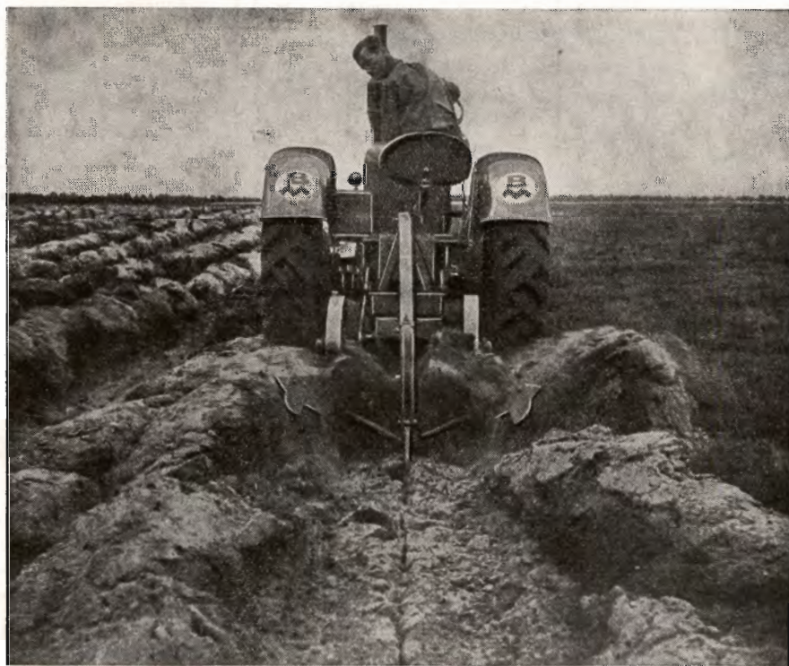
Munktell's-Traktoren med indbygget Plov og Grubber klarer Pløjning af Hede med kun Een-Mands-Betjening
