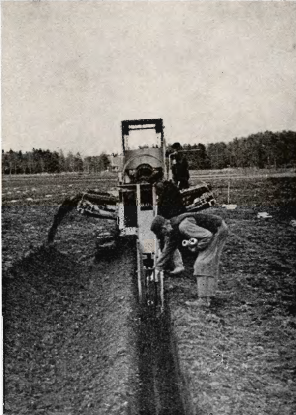
Fig. 2. Parson-Maskinen i arbejde. Føreren står på maskinen og sigter hen til de opstillede mirer. Rørlæggeren går langs maskinen og lægger rørene, medens medhjælperen lægger rør på slidsken. Det ses ligeledes, hvorledes fylden kastes ud til siden.
