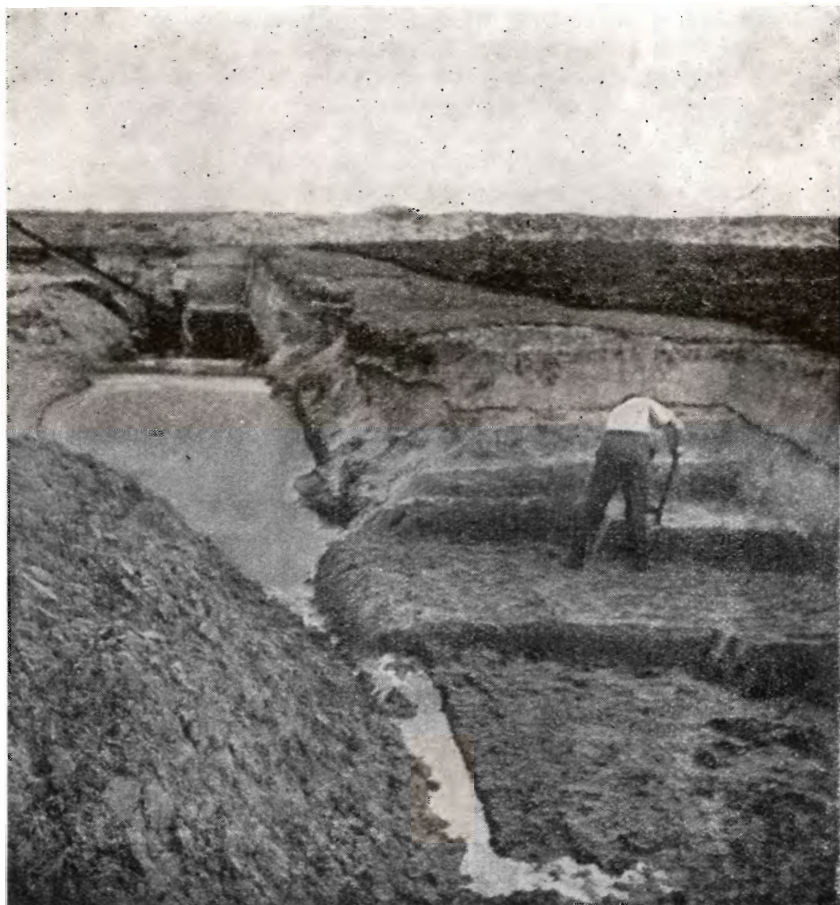
Afrømning af ca. 2 m Sand for Tørvegravning i Sandmosen. Den sorte Linie i Højde med Arbejderens Hoved er dannet af en tidligere Lyngskjold. I Baggrunden til venstre skimtes Elevatoren til Tørvepresseren.
