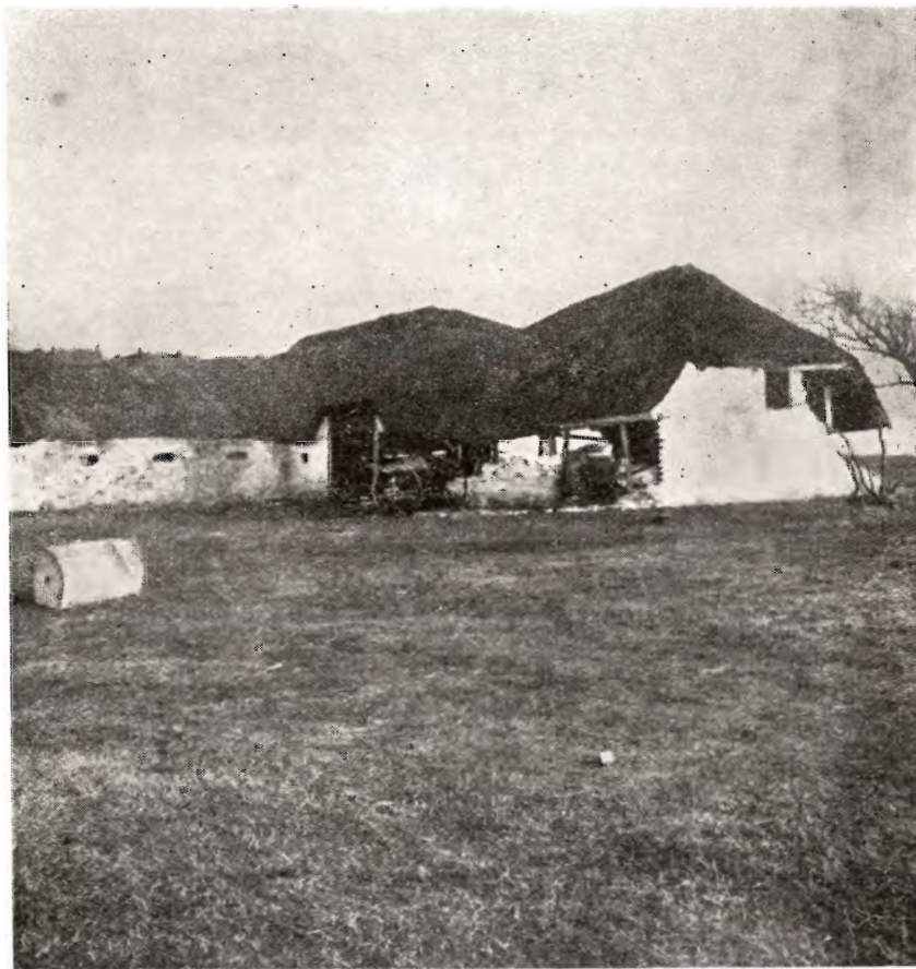
En forladt Gaard ved Sandmosen. Lod Nr. 24. Løse Kreaturer har væltet Lademuren, der kun har en halv Stens Tykkelse.
