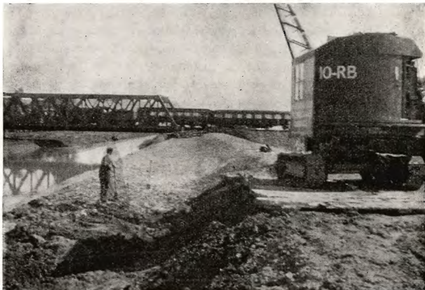
Digearbejde ved større vandløb i nærheden af Cambridge.
