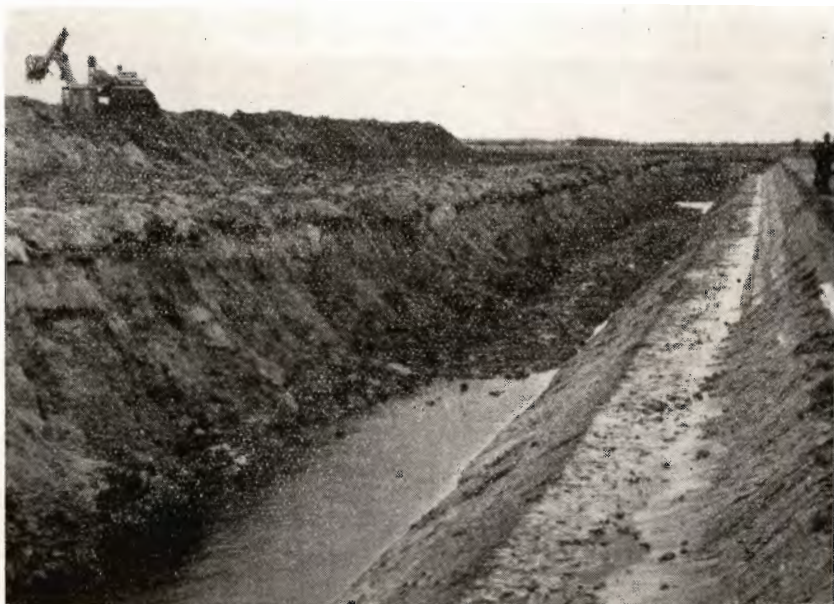
Kanalarbejde i Udbyneder.
