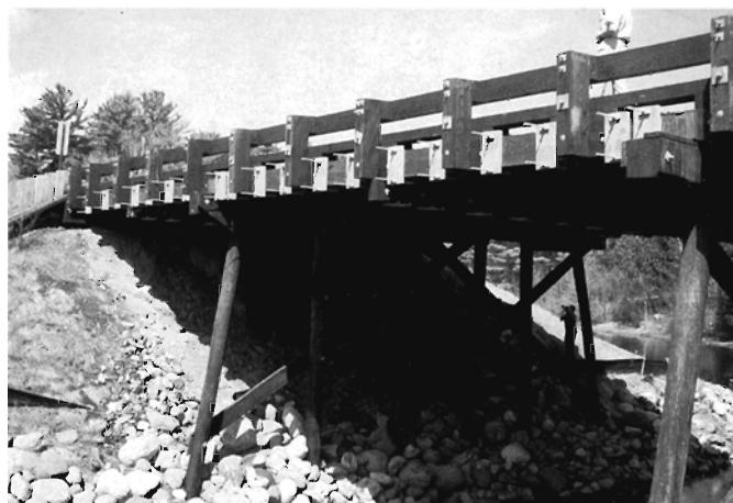
Foto 2. En 5 år gammel hovedvejsbro, 28 m lang og 12 m bred. Broen er bygget af douglasgran, der er imprægneret med tjæreolie. Broen har fra begyndelsen været konstrueret for svagt. Brodækket er siden forstærket med en tillempet forspændt laminering. Det er en bro lavet af en "money-maker". (Chief River Bridge, Wisconsin, USA).
