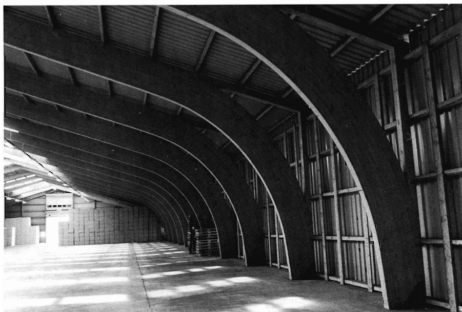
Det skal gøres lettere at beregne og anvende træ i fx. byggeri. (Foto af lagerhal med spær af limtræ).
