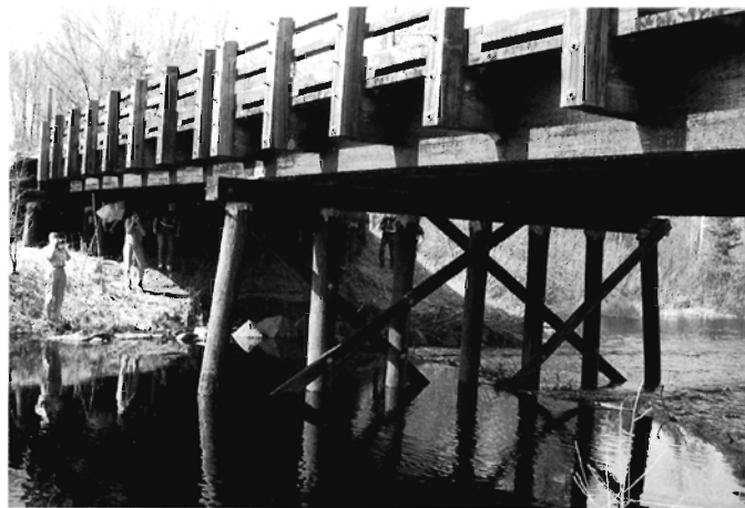
Foto 1. En 20 år gammel vejbro, 24 meter lang og 7 m bred. Broen er bygget af laminerede douglasgran-bjælker, der er imprægneret med tjæreolie. (Brunsweller River Bridge, Wisconsin, USA).
