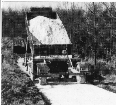
Levering og udlægning af grus, sten og andre vejmaterialer direkte fra lastbil med patentanmeldt vejafjettermaskine.
