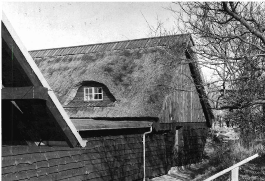
Foto 1. Bolig og kontor ved Jels Savværk. Bygget helt i grantræ i 1864 og stadig i brug.
