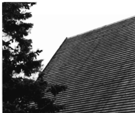
Foto 5. Taget på "Granhuset" er imprægneret med carbolineum og bruntjære. Brædderne blev lagt i 1963 og er stadig fuldt intakte.
