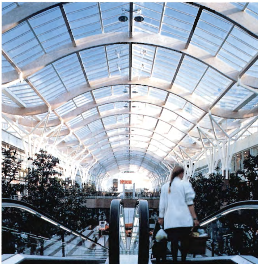
Glastag i et indkøbscenter i Frankfurt, båret af 30 m lange limtræbjælker. Der er valgt limtræ, fordi det opfyldte det arkitektoniske og brandmæssige krav til form og styrke. Glasoverdækningen er udført i forbindelse med renovering af et nedslidt indkøbscenter fra 60'erne.
