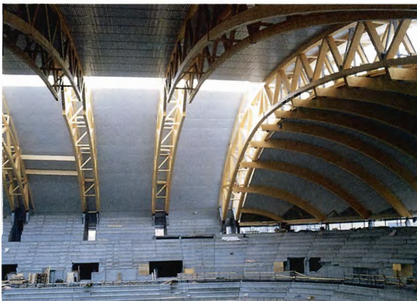
Foto 3. Haakonshallen har en spændvidde på 85 meter eller 20 meter mere end hvad der hidtil har været muligt.
