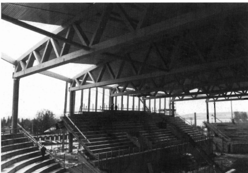
Foto 4. Den nederste bjælke i spærene i Nordlyshallen er vandret, og det krævede en videreudvikling af knudepunkterne for at kunne overføre de enorme kræfter.
