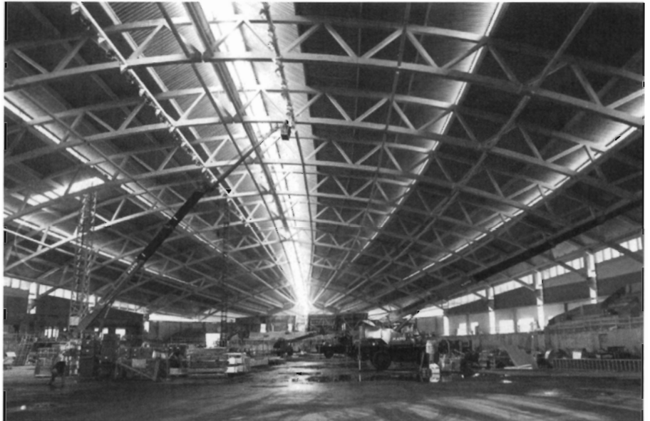
Foto 1. Vikingskibshallen har en spændvidde på op til 96 meter eller næsten 50% mere end hvad der hidtil har været muligt at konstruere med limtræ.
