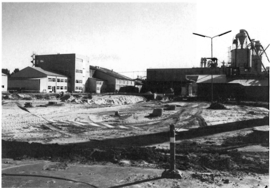
Figur 2. En ny kontinuert presse vil blive sat i drift ved årsskiftet 1991-92. Lige nu er man i gang med støbning af fundamenterne (foto ultimo august).
