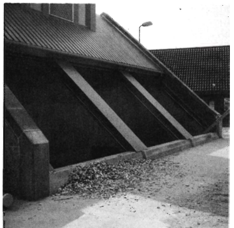
Fig. 2. Det er vigtigt, at flisen kan aftippes direkte fra lastvogn i en overdækket silo ved varmeværket. Eksemplet viser en 200 m 3 stor aftipnings-silo ved Skørping Varmeværk.
