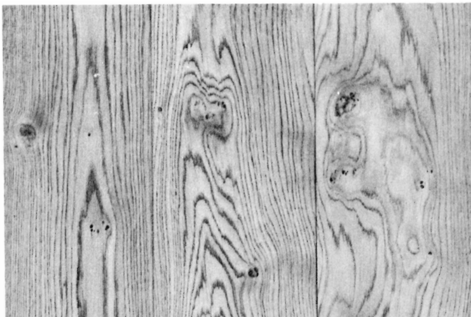
Fig. 3. Det færdige gulv, der er opbygget af 3 lag. De enkelte planker samles med fjer og not i siderne.
