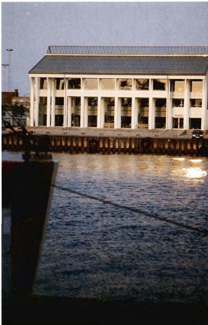
Figur 1. Festlighederne ved Dansk Skovforenings 100 års jubilæum indledes ved "Paustians hus" i Nordhavnen i København. Huset er indviet for nylig og er tegnet af Jørn Utzon, som har ladet sig inspirere af de høje slanke bøgestammer da han tegnede huset med de kraftige søjler.
