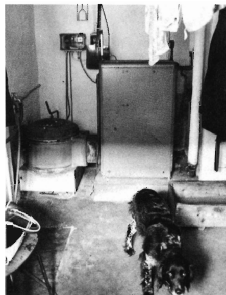
Fig. 1: Forfyr bygget til gammel kedel i skovfogedstedet på Petersgård af Skovmas. Årsforbrug ca. 50 rummeter flis (17m 3 f.). Flislag og -silo bag muren til venstre. Bemærk vasketøjet!
