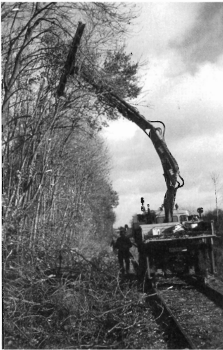
Figur 6. Fritrumsprofilen vedligeholdes ved at skære træer og buske tilbage eller ved at fælde dem. Her skæres træer tilbage vha. en grenhøvl på en troljemonteret kran.
