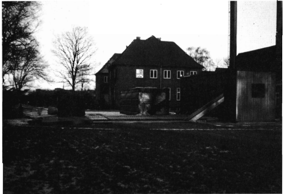
Fig. 1: Institutionen Løgumgårds flisfyringsanlæg. Anlægget er leveret færdigmonteret fra fabrik i det isolerede containerlignede stålhus. Flissiloen, kun svagt synlig, er nedgravet til venstre for anlægget.
