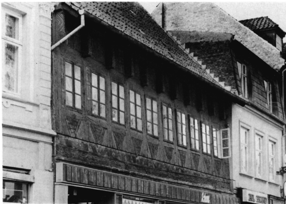
Fig. 2. Denne overgangsfod med udskæring, som øverste stokværk hviler på, skulle restaureres og imprægneres. Her var musketkuglen gået ind for mere end 300 år siden.
