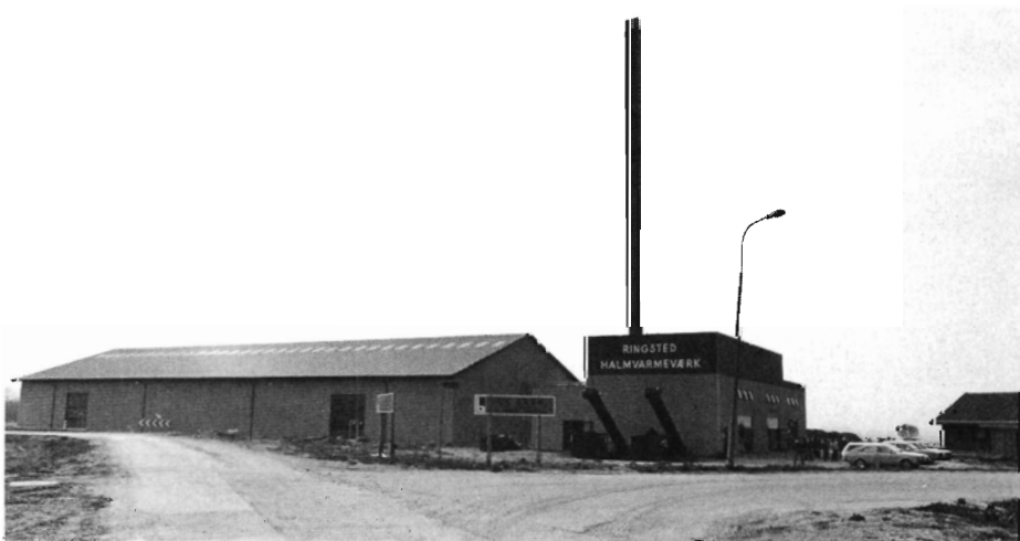
Fig. 1. Ringsted Halmvarmeværk, fra venstre lagerhal, kedelbygning og varmemesterbolig.
