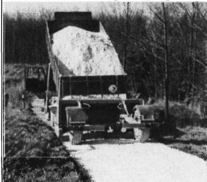
Levering og udlægning af grus, sten og andre vejmaterialer direkte fra lastbil med patentanmeldt vejafrettermaskine.
