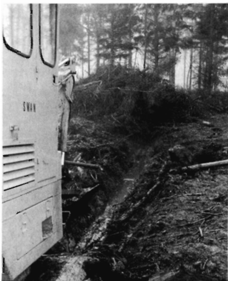
Fig. 3. Rydning af grøftelinien forud for gravearbejdet er vigtig, og man bør ikke placere kvasdynger over grøftelinien, som det fremgår af billedet.
