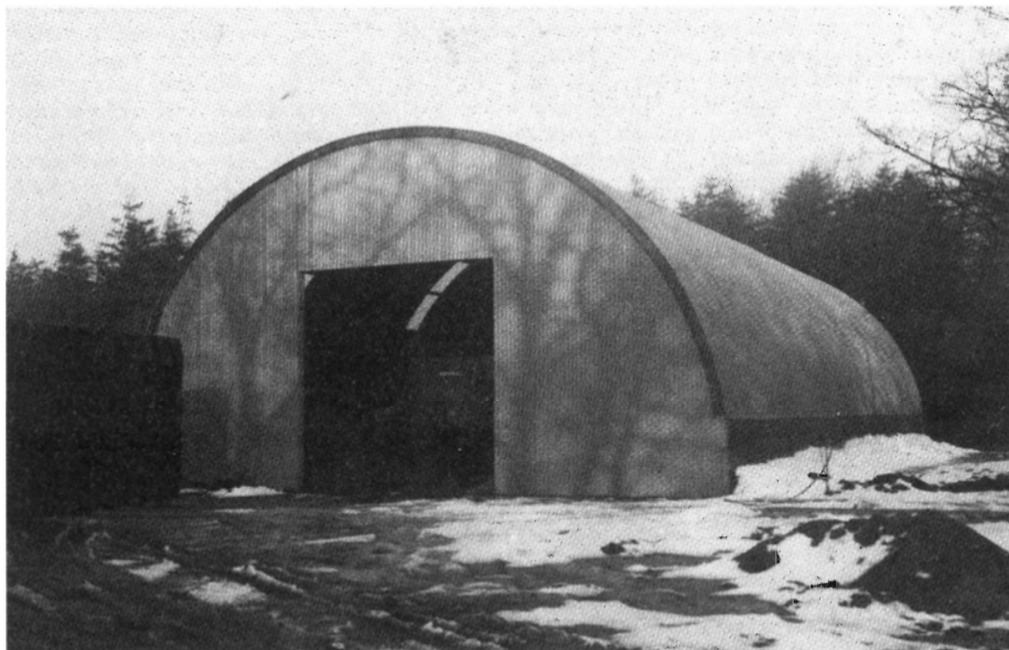
Eksempel på lagring af flis under tag, her en rundbuehal på Lindet skovdistrikt. (Foto: Ole Klitgård, fra Ugeskrift for Jordbrug 9/86).
