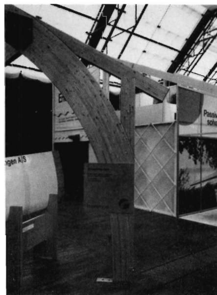
Figur 2. Rammekonstruktion. Klemt hjørne med stikspærstolpe, monteret med indlimede bolte. Spændvidde 12 m. (Flexwood på Falster).
