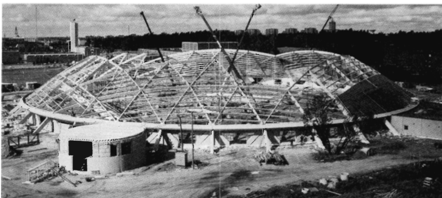
Sportshal i Uleåborg med en spændvidde på 115 meter konstrueret med bjælker af krydsfinér.
