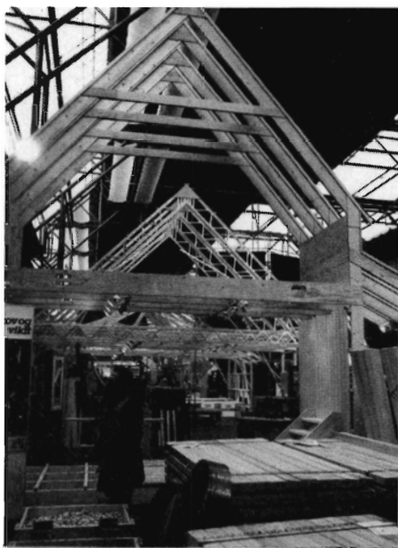
Figur 1. Spærfag af træ, forrest TT-Frame System (Tåsinge Træ) bagved letbjælker (Kartro).
