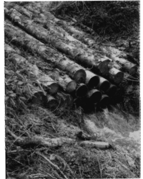
Figur 2. Faskinen udgør en let og mobil bro og forstyrrer ikke afstrømningen i vandløbet. Her er selve rørfaskinen beskyttet af et antal tømmerstokke.
