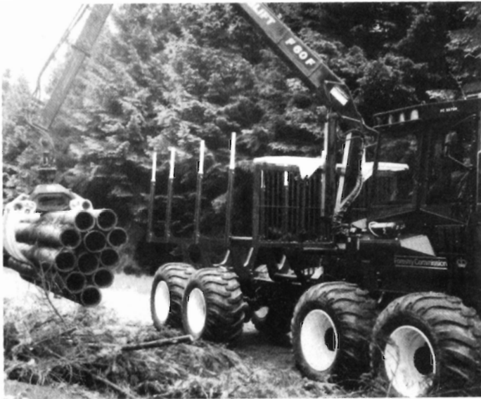
Figur 1. Rørfaskinen består af 9 - 18 rør og udlægges ved hjælp af en udkørselstraktor.
