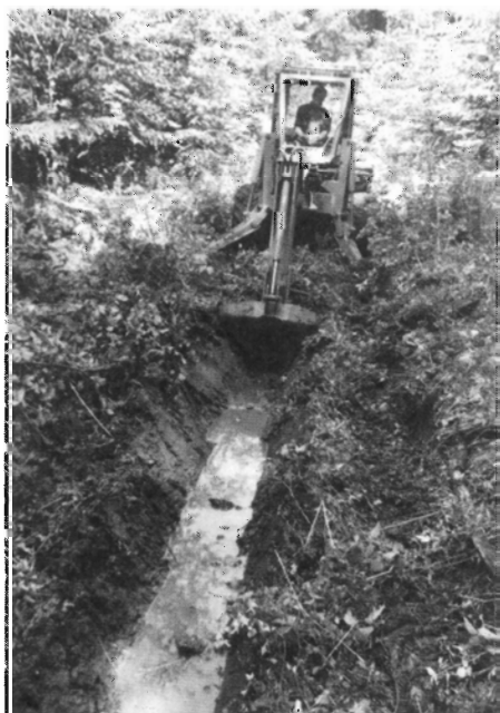
Figur 1. Oprensning med Klaus Lorentzens Case gummihjulgraver.
