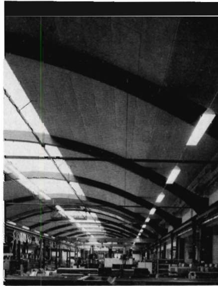
Figur 2. Eksempel på brug af træbetonplader til loftsbeklædning, fra A. M. C. Maskin Compagni A/S Århus.
