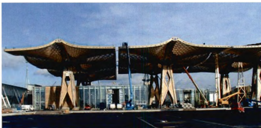
Foto 1. Expotaget under bygningen, hvor man ser samlingen af de enkelte dele.
