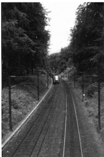
Figur 3. Kystbanen få år efter beskæring. Bemærk den kraftige naturlige opvækst på skråningerne. Disse blev ryddet for træagtig vegetation i forbindelse med elektrificeringen. Foto: Erik Elsborg, Oing. DSB EKO.
